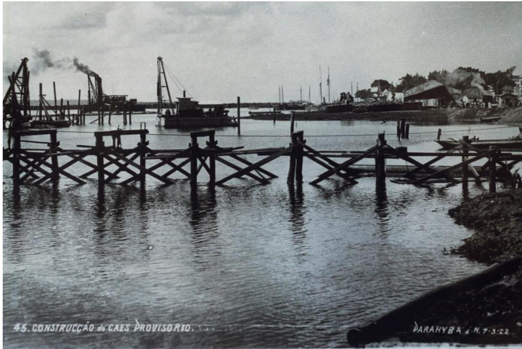
Figura 02: Transferência da função portuária de João Pessoa. Construção do cais provisório.
