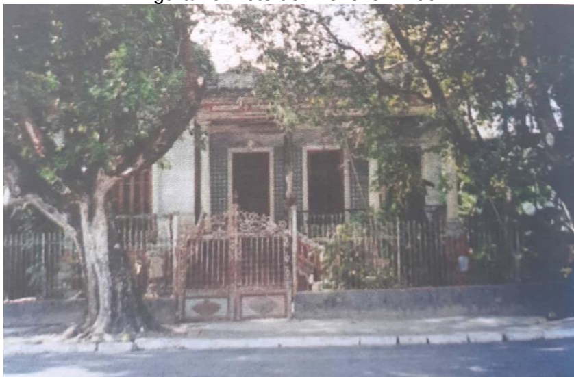
Figura 10: Foto do imóvel em 2001
