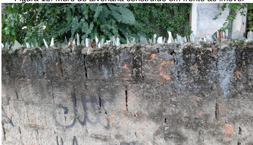
Figura 15: Muro de alvenaria construído em frente ao imóvel
