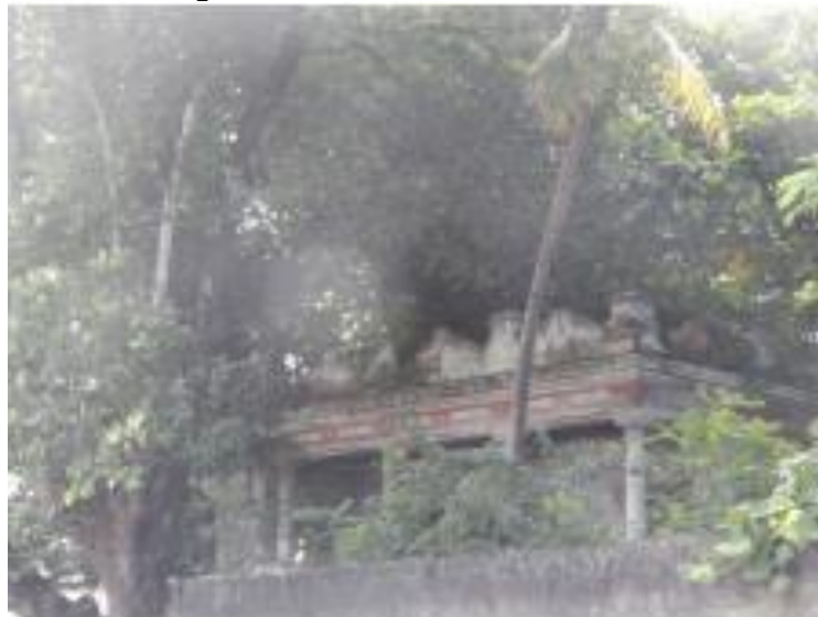
Figura 12: Foto do imóvel em 2019
